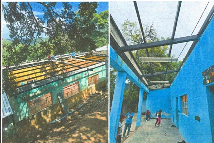
Foto1: Cambio de lámina troquelada calibre 26, con lijado y pintado de la estructura metálica de techo existente, e instalación de canal metálico con bajadas pluviales en tubo PVC de 3" color blanco
