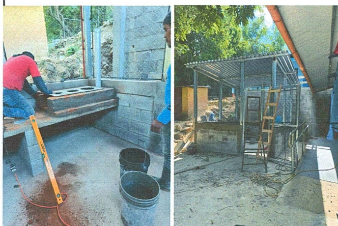
Foto 2: Suministro e instalación de cocina tipo pórtico, con puerta, polleton, plancha de 3 hornillas y chimenea
